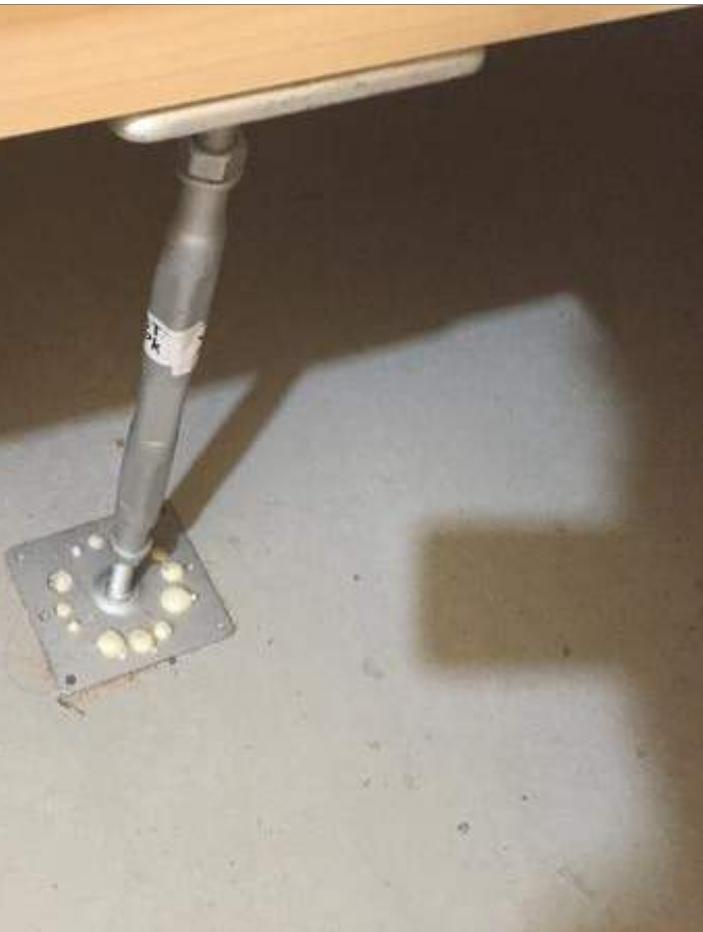
1-13 □接合金物の種類・施工位置が図面通りか確認する。(1/2)
