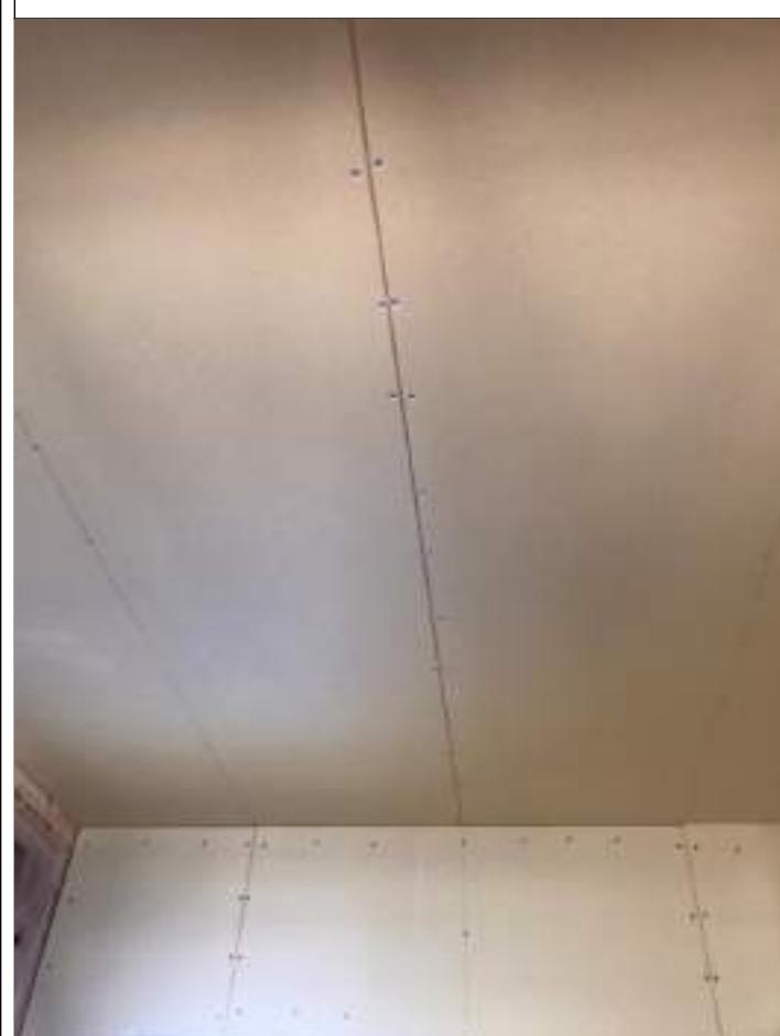
1-15 くぎ打ち間隔は外周100mm以内、中間部200mm以内の間隔で留め付ける。(2枚張りの場合) くぎ打ち間隔は外周部及び中間部とも200mm以内とする。(1/2)
